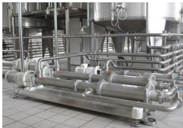
Насосы Муано Серии Н для свежих молочных продуктов: Транспортировка белой массы к теплообменнику и далее к линии розлива
